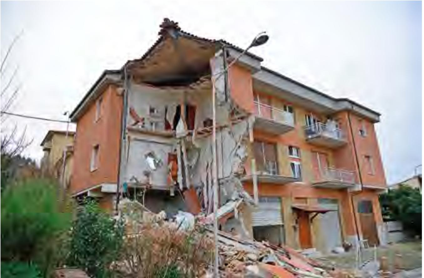
**Foto 3 - Edificio parzialmente crollato con struttura portante in muratura ed orizzontamento in laterocemento - Comune di San Severino Marche (MC) - Quartiere Settempeda.**
